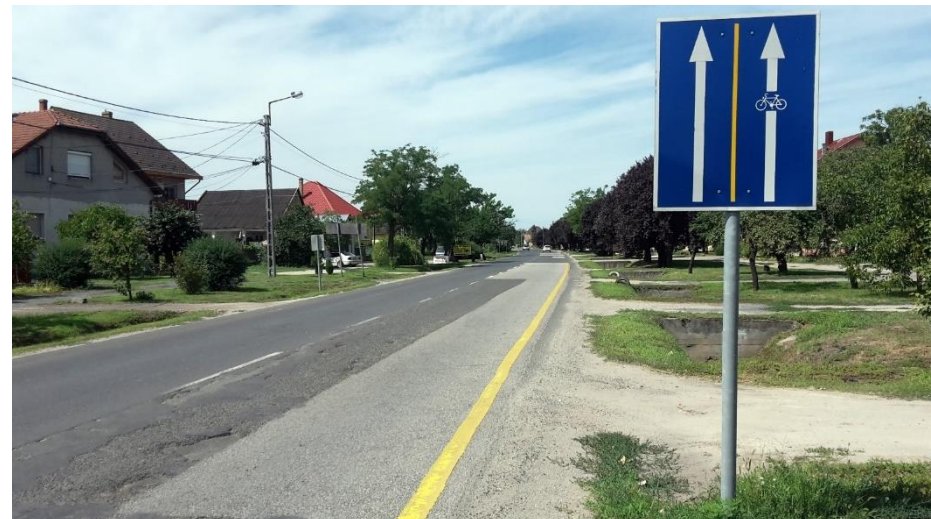
3-12. ábra: Halász Károly utca – Ócsai út között kétoldali, irányhelyes kerékpársáv Forrás: saját fénykép
