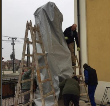
A kökereszt téliesítése: a ponyvával való letakarás véd a fagyok ellen és segít megőrizni a szobor állapotát.
