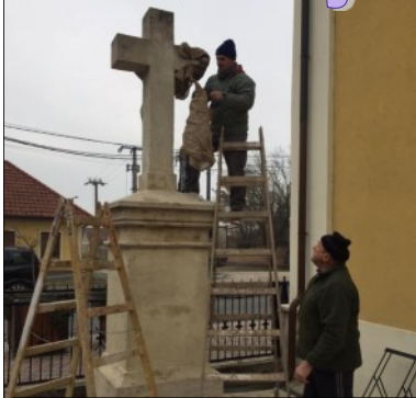
A kökereszt téliesítése: a ponyvával való letakarás véd a fagyok ellen és segít megőrizni a szobor állapotát.
